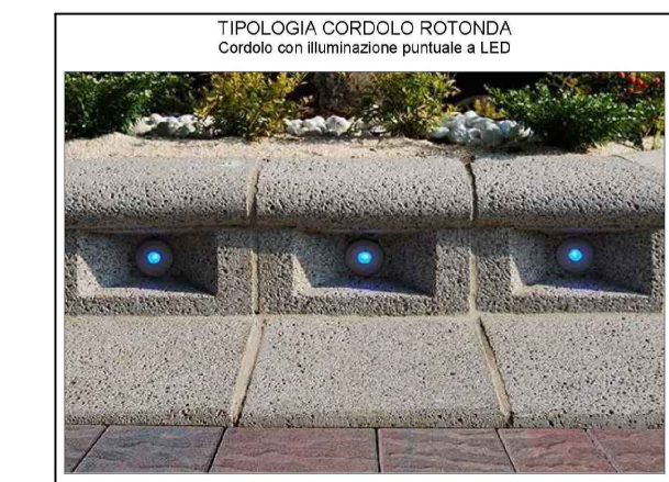
Particolare Impianto di Illuminazione a "LED" - Rotatoria
